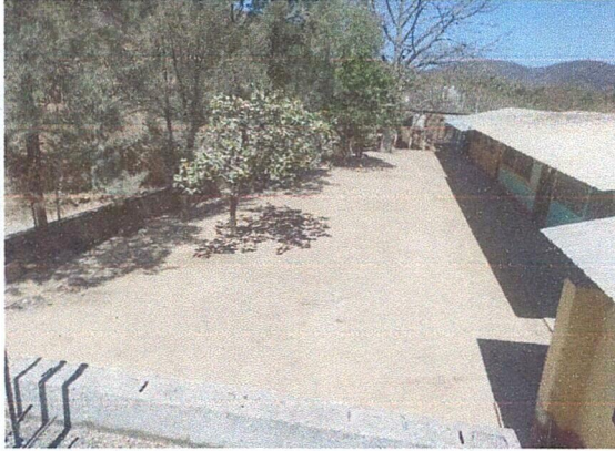
Foto 1: Colocación de losa de concreto en el patio de la escuela y su respectivo techo con lámina troquelada calibre 26, su estructura metálica de tubos galvanizados chapa 16, con su canal y bajada de agua pluvial.
